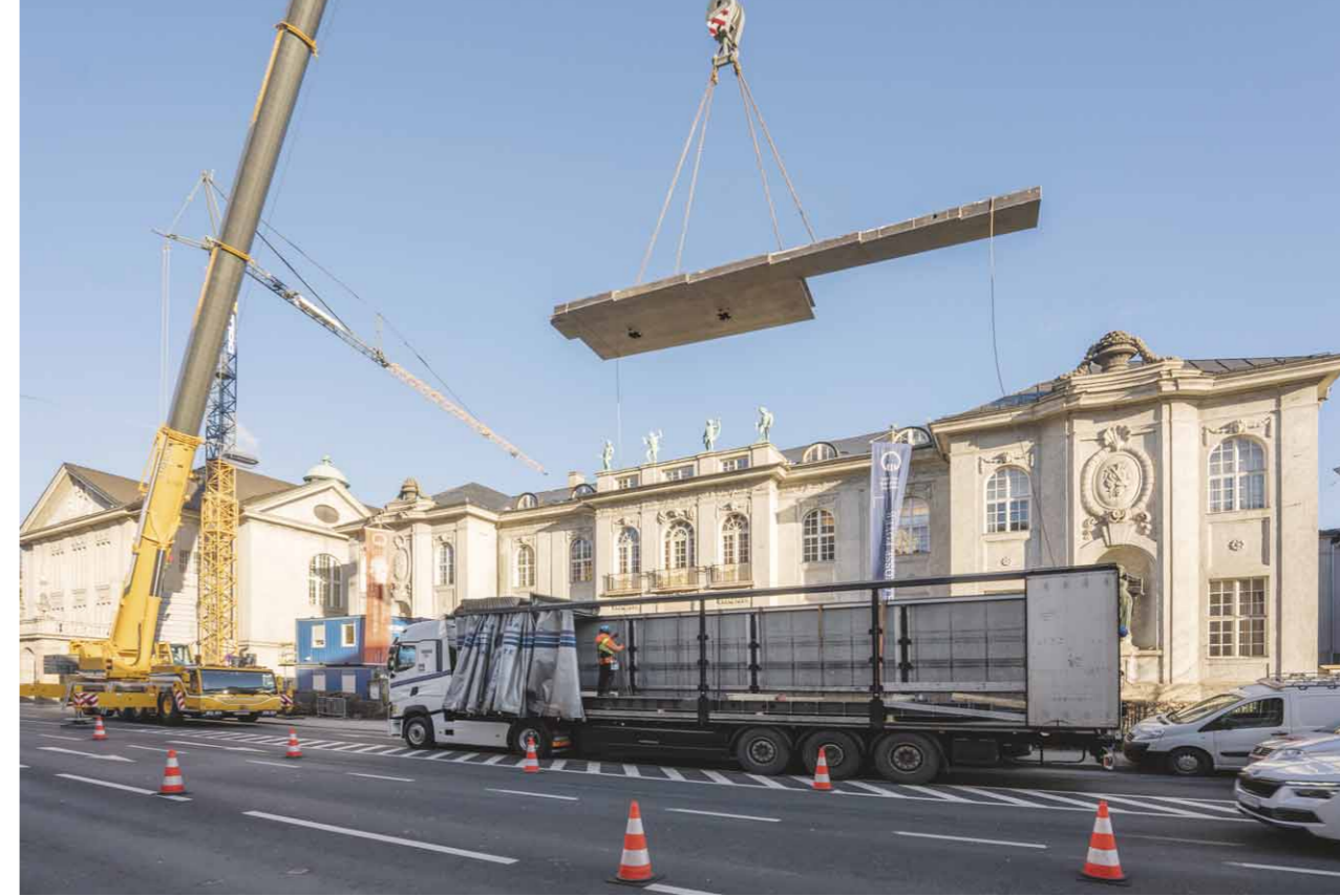
Anlieferung der Stahlträger im Dezember 2021
