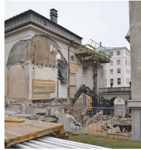
Abbrucharbeiten im Innenhof
